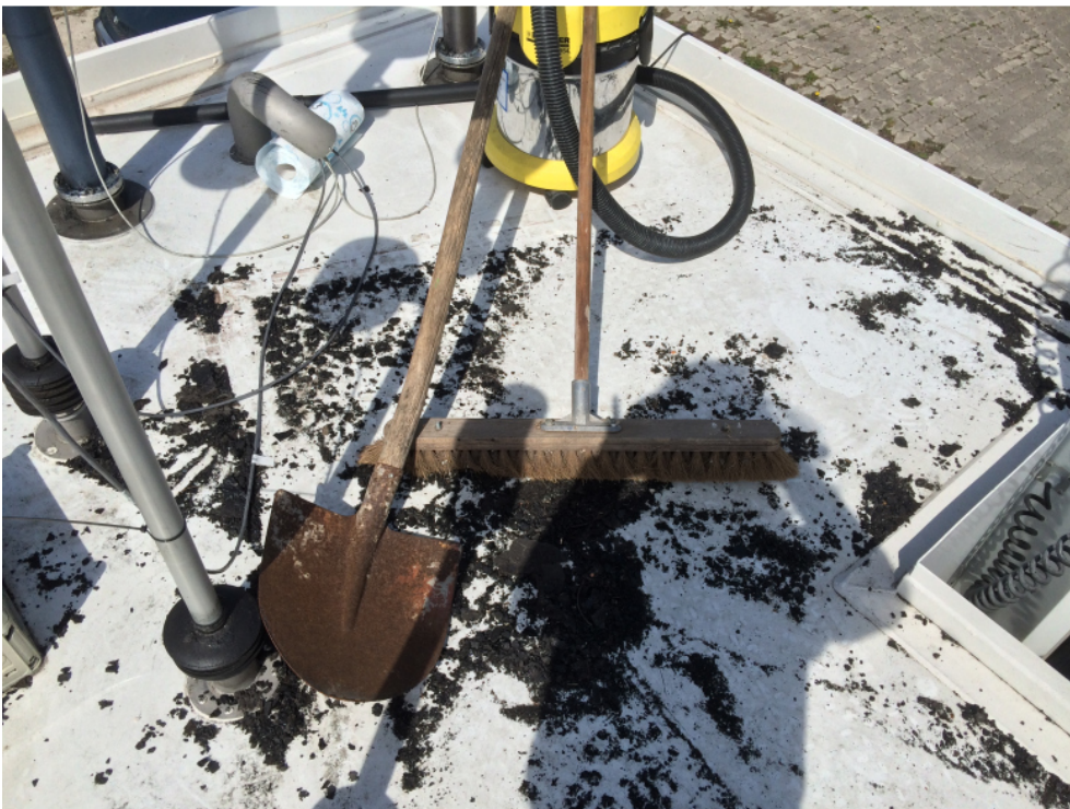
Abbildung 17. Sturmschäden der mobilen LGM (Pulling) – Bild 2 (09.04.2015).
